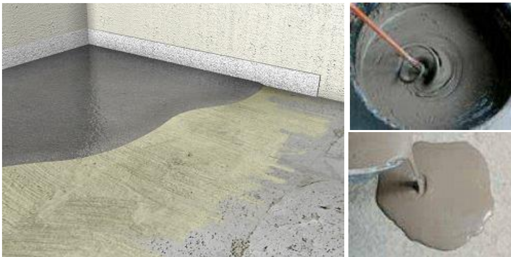
Figura 8: Esquema de aplicación del mortero autonivelante. Fuente: CYPE Ingenieros SA.
