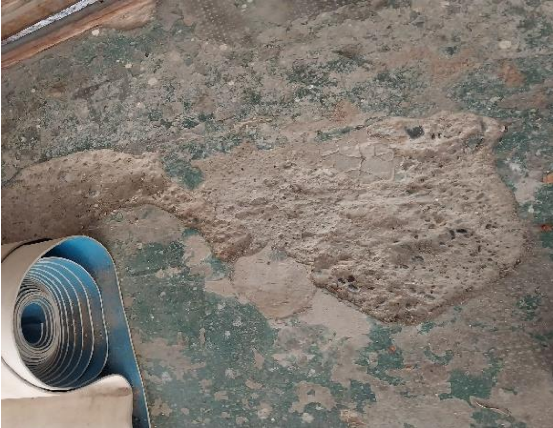
Figura 5: Manchones y sectores carcomidos del piso. Fuente: Elaboración propia.
