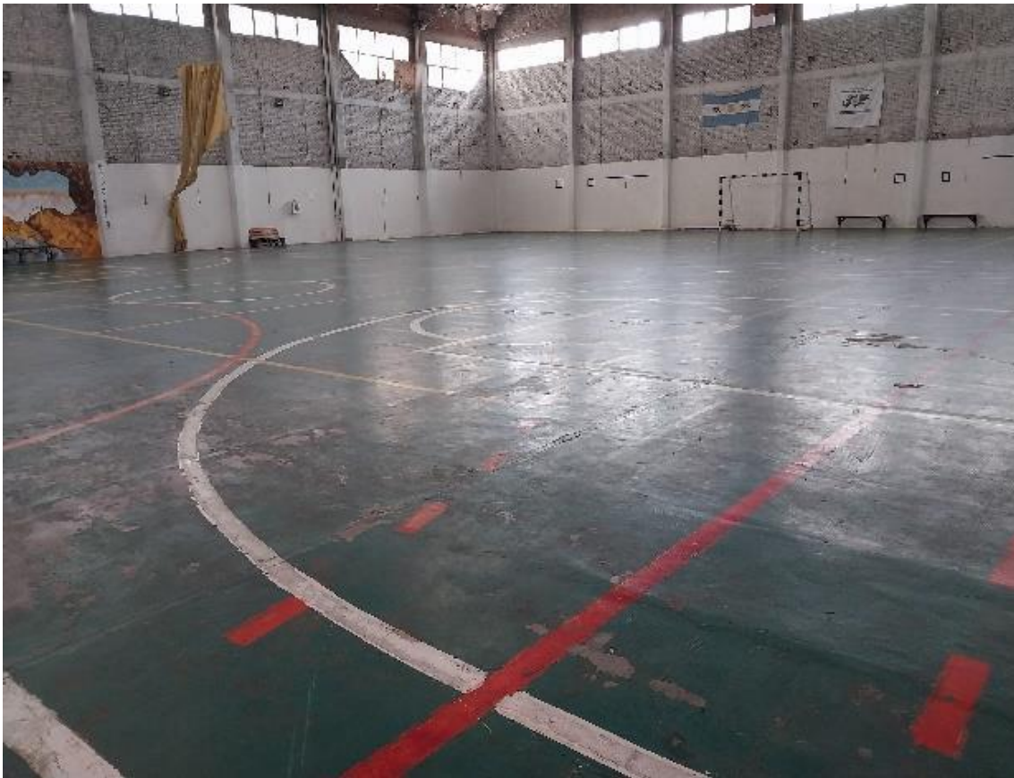
Figura 2: Panorámica que evidencia los desniveles en el contexto de la cancha. Fuente: Elaboración propia.
