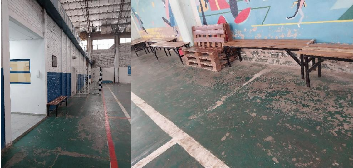
Figura 3: Desgaste evidente en los laterales de la cancha. Fuente: Elaboración propia.
